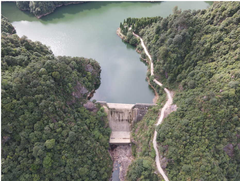
图 2.4 水源宫信联三级电站水库现场图片
