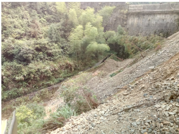
图 4-1 必背村必背坑梧桐坝漏水示意图
