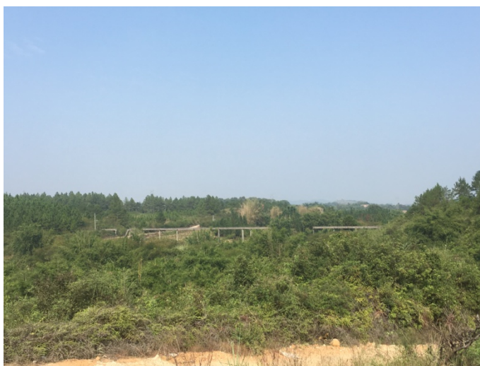
图 4-2 一六镇横冲水库灌溉渡槽垮塌示意图
